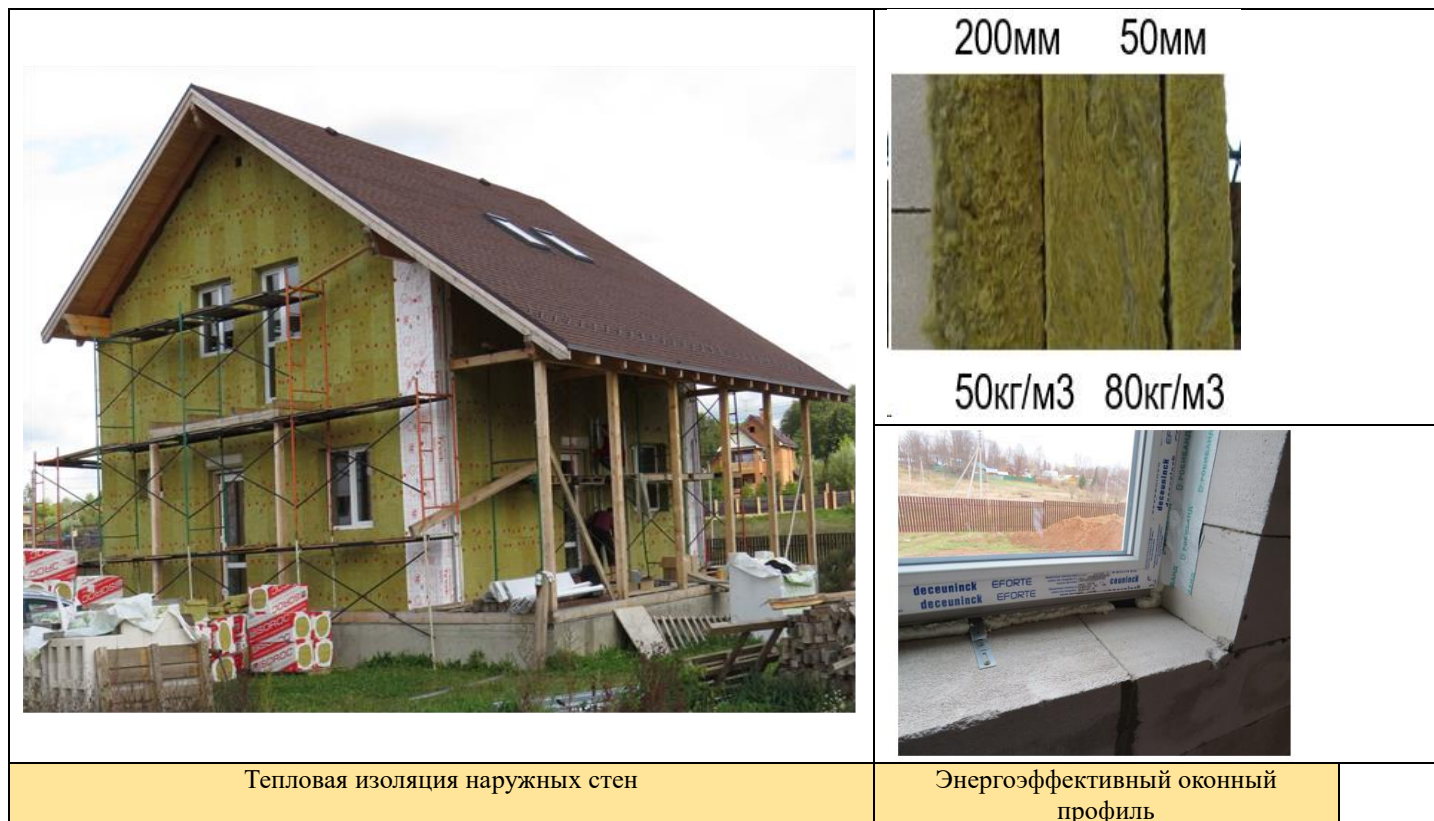
Рисунок 2. Тепловая изоляция наружных стен и энергоэффективный оконный профиль (этап строительства здания, май-ноябрь 2016 г.)
