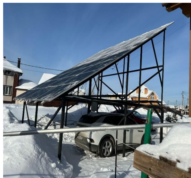
б) этап эксплуатации навеса с солнечными фотоэлектрическими панелями (февраль 2024 года)
